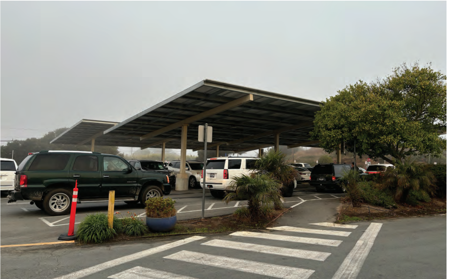
Estacionamiento de Elkhorn Elementary.
