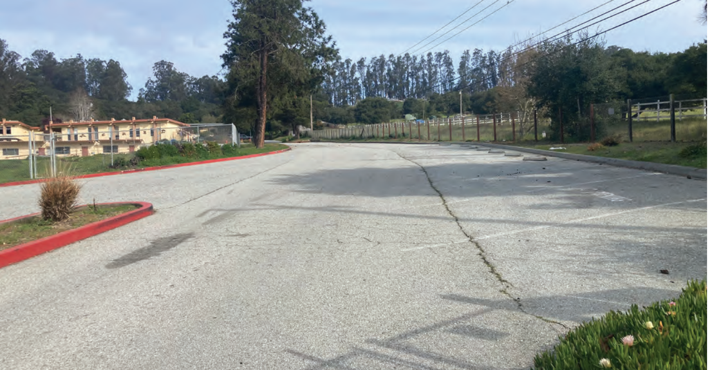
Estacionamiento de Echo Valley Elementary.
