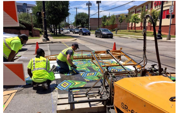
Figura 6: Instalación de termoplásticos
